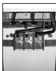
Utility lug landing
