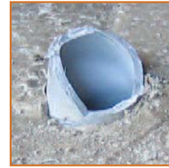
Broken conduit on jobsite
