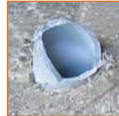
Broken conduit on jobsite
