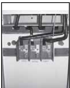
Utility Lug Landing
