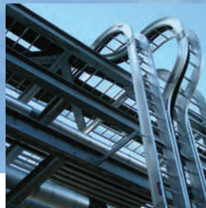
PW Cable Tray
