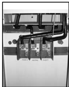
Utility Lug Landing
