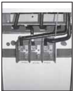
Utility Lug Landing
