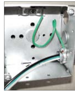
LNG-50 IN USE
