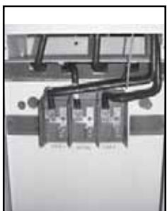
Utility Lug Landing
