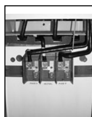
Utility lug landing
