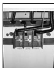
Utility lug landing
